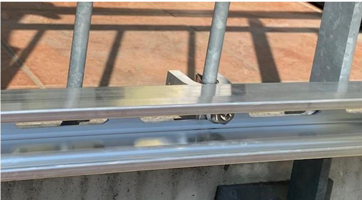
Abb.g 11/Montageschiene und Spezialklemme von außen
