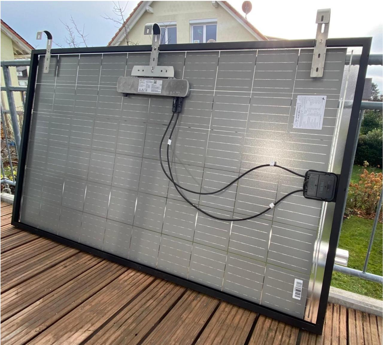
*Abb.7/vorbereitetes Solarmodul mit 3 Befestigungsbügel und Wechselrichter*
