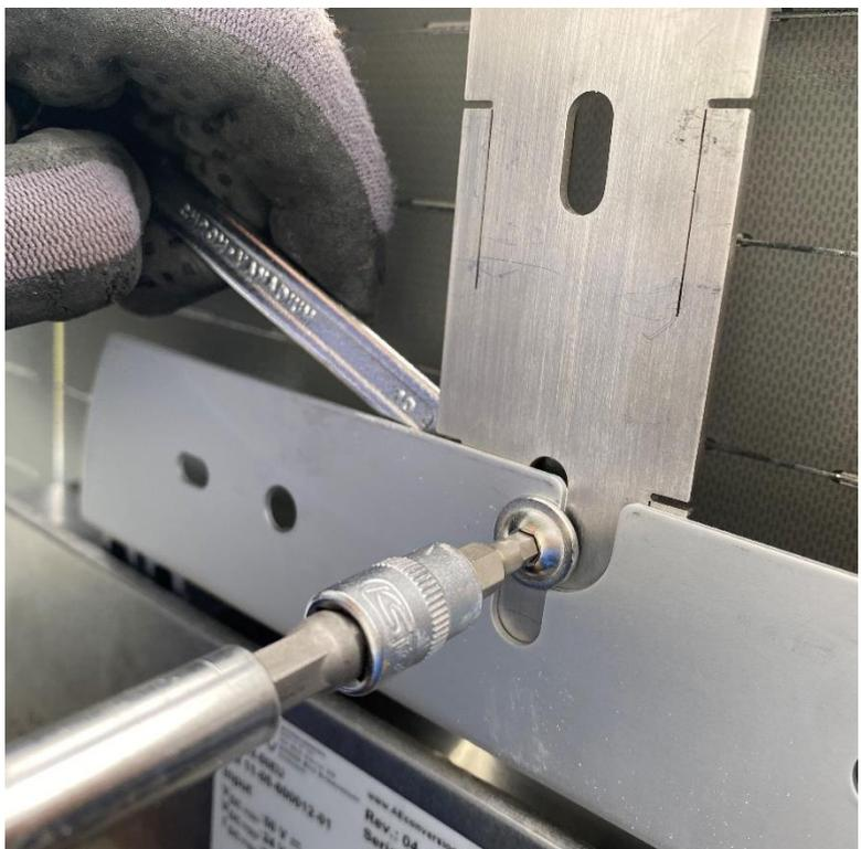
Abb. 6/Wechselrichter am SOLAR-HOOK Befestigungsbügel anschrauben
